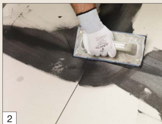
Очистка по завершению строительных работ
