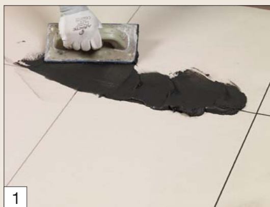
Затирка и первичная очистка
