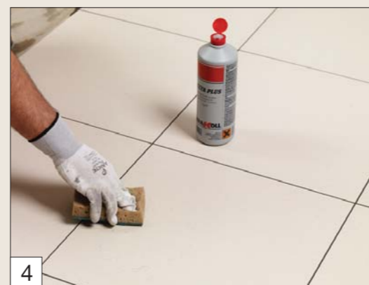
Pulizia di fine cantiere
