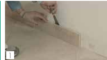
1 Eliminare il battiscopa Remove skirting
