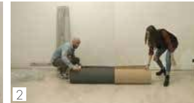
2 Stendere il tappetino Lay the underlayer
