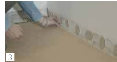
3 Posizionare i distanziali lungo il perimetro Fit the spacers around the outer edge
